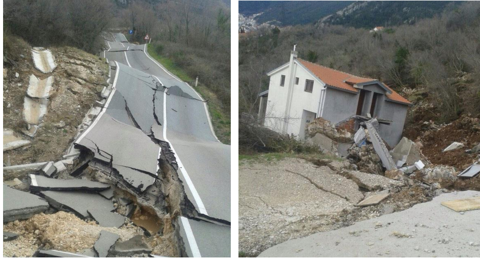
Slika 6. Plastične deformacije, pojava klizišta
