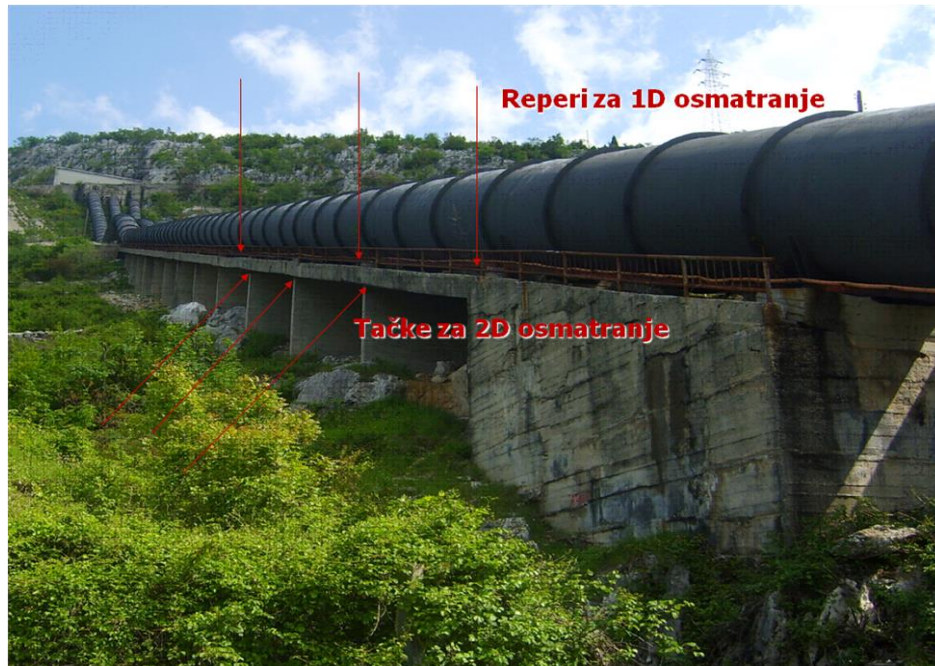
Slika 1. Tačke za osmatranje na objektu "Cjevovod Perućica".
